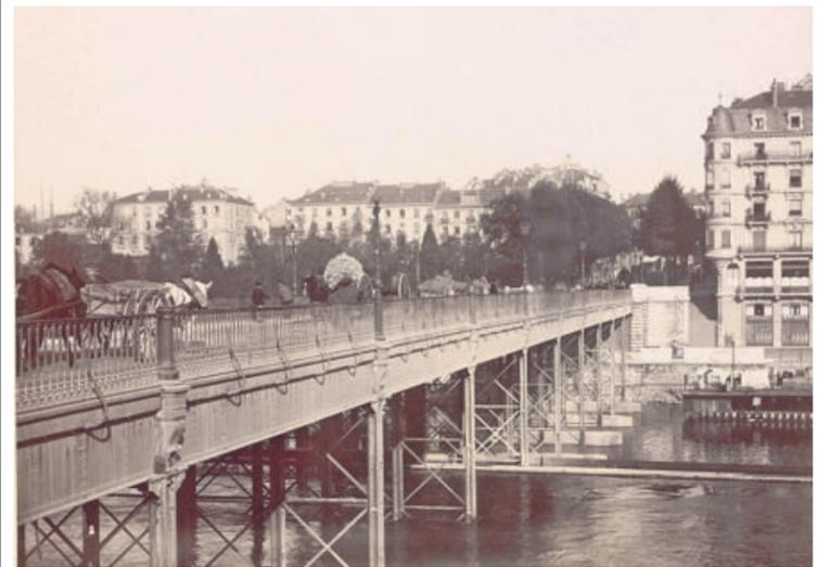
**Le pont de la Coulouvrenière (II/V)** Longtemps, le pont de la Coulouvrenière fut le dernier pont genevois situé en aval sur le Rhône. Construit en 1856-1857 par l'ingénieur polonais Blotzniki afin de relier les boulevards fazystes des Rives droite et gauche, le pont, avec ses fines poutrelles métalliques, n'aurait pu supporter le trafic de l'Exposition nationale de 1896, qui s'est tenue à Plainpalais. Il fut donc démolé à la fin de 1894 et remplacé. COLLECTION CENTRE D'ICONOGRAPHIE GENEVOISE
